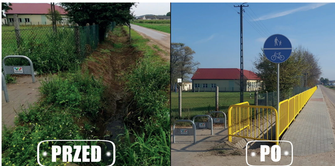
Wybudowany ciąg pieszo-rowerowy w Kotach
