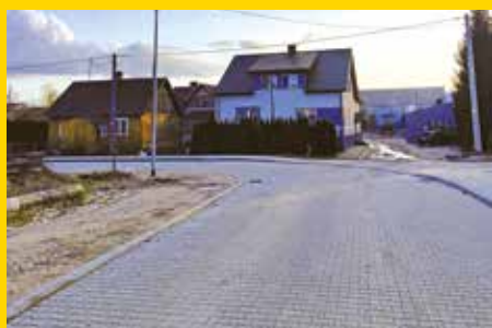
Inwestujemy w drogi str. 5
