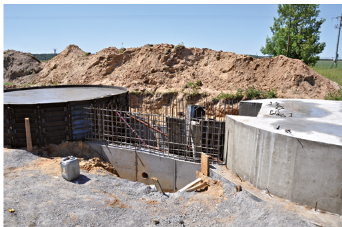
Stacja uzdatnia wody w Podgórzu w trakcie przebudowy
