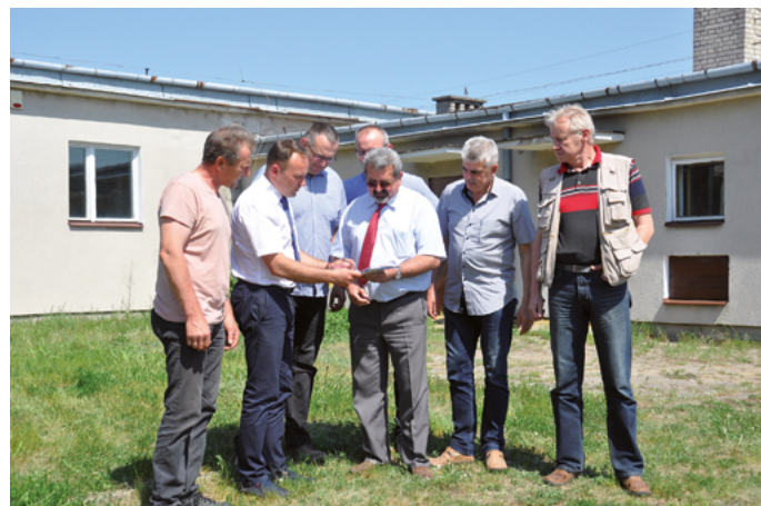
Przekazanie placu budowy SUW-ów w Starych Modzelach i Podgórzu
