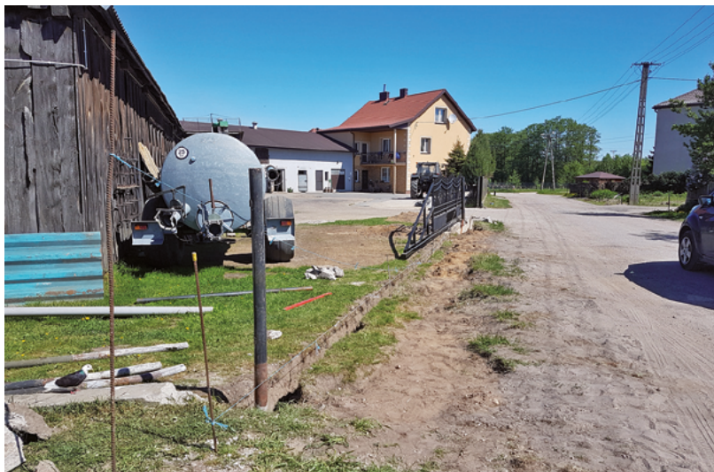
Obecny stan drogi w Starych Sierzputach
